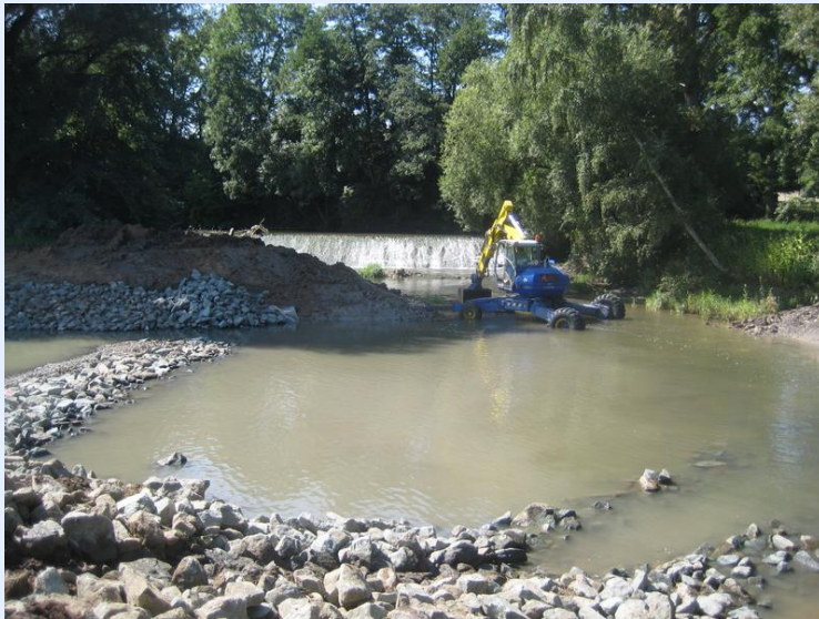
Verlegung der Ilm an der Obermühle Zottelstedt/Ilm
