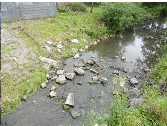
Bild 4: Durchgängiger Gewässerabschnitt nach dem Rückbau der Sohlstufe
