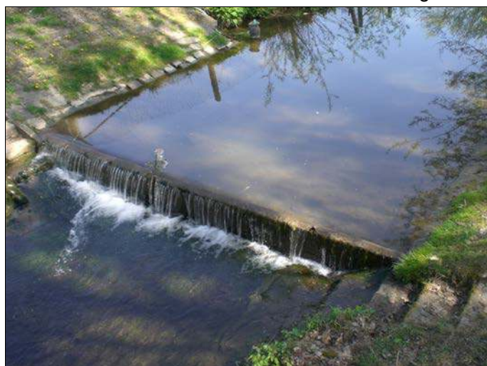
Bild 3: Sohlstufe in Simmershausen
