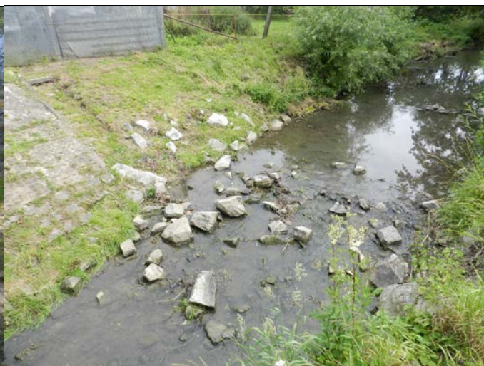
Bild 4: Durchgängiger Gewässerabschnitt nach dem Rückbau der Sohlstufe
