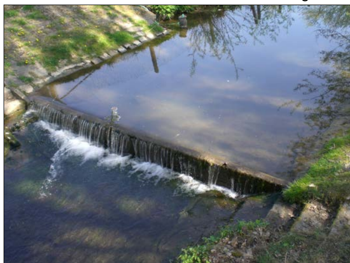
Bild 3: Sohlstufe in Simmershausen
