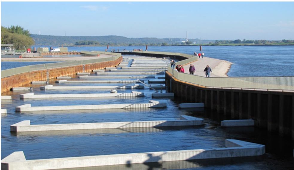
Abbildung 5-3: Wehr Geesthacht, Strom-km 586, Blick auf die Fischwechseleinrichtung am Nordufer (Quelle: Th. Gaumert)
