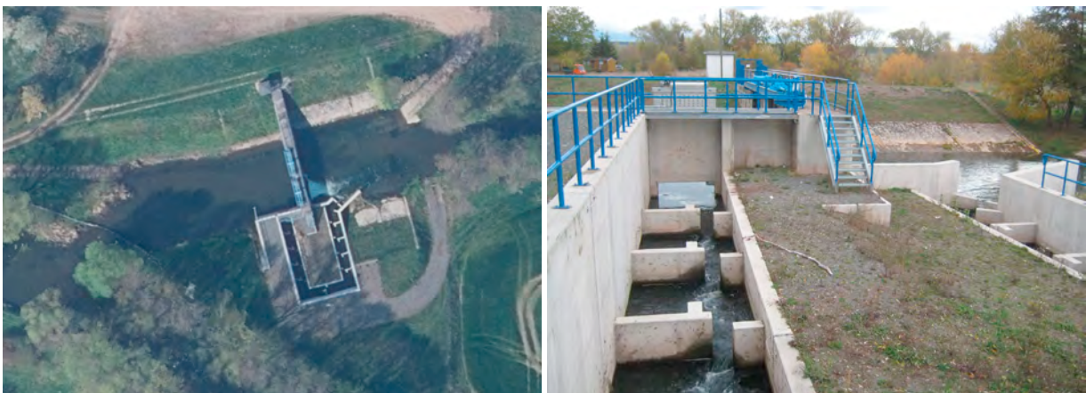
Abbildung 28: Luftbild (links) (Quelle: © GDI-Th) und Foto der Fischaufstiegsanlage in der Nebenhelme bei Görsbach (rechts) (Quelle: TLUBN)
