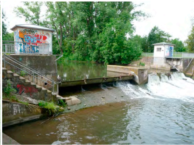
Abbildung 27: Wehr Teichmannshof in Erfurt vor dem Umbau (Quelle: TLUBN)
