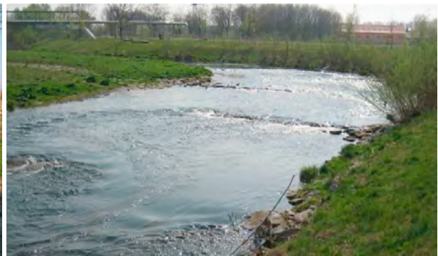
Abbildung 32: Neue Flussschlinge der Gera (Quelle: TLUBN)
