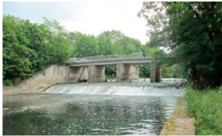
Abbildung 29: Wehranlage Gispersleben vor dem Umbau (Quelle: IWSÖ GmbH, Weimar)
