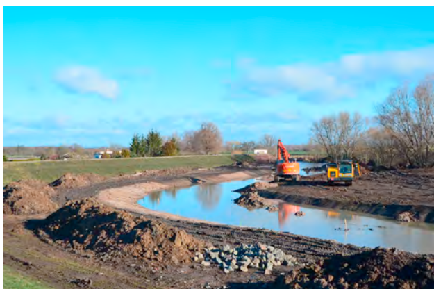
Abbildung 35: Naturnahe Umgestaltung der Gera bei Walschleben im Bau (Quelle: Andraczek, I.)
