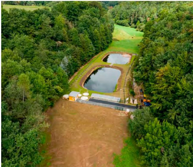
Abbildung 46: Kläranlage Thalwenden im OWK Leine (Quelle: Kaufhold WAZV Obereichsfeld)
