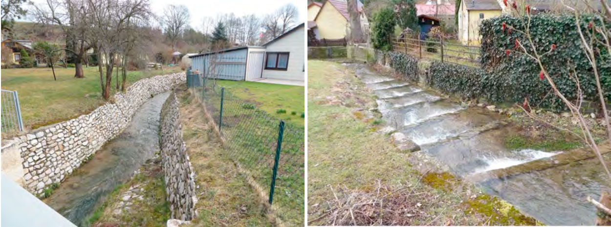
Abbildung 22: Verbau an der Leutra in Maua (Quelle: TLUBN)
