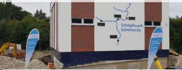
Schöpfwerk Sömmerda Bautenstand 09/2021 (Quelle: TLUBN)
