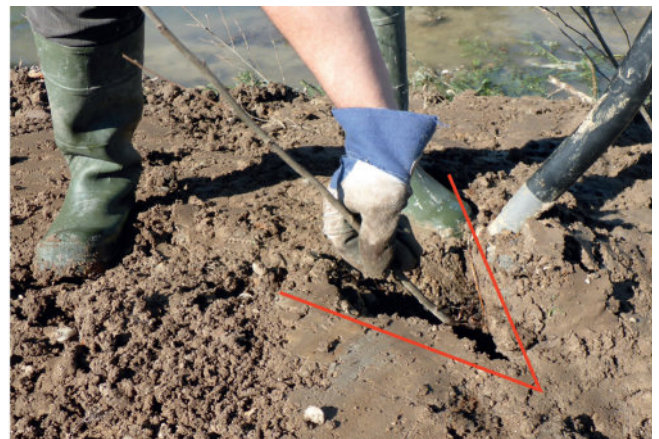
Foto 16: Tiefes und leicht schräges Einstechen mit dem Spaten, Spaten anheben, einen Spalt ausbilden und in diesen die Pflanze einlegen. (Foto: A. Stowasser)
