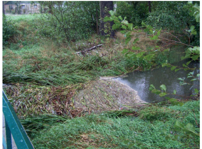
Foto 94: Schwemmgutansammlung aus pflanzlichem Material. Verursacht es einen Rückstau an Brücken und Durchlässen ist eine Beräumung i. d. R. erforderlich. (Foto: A. Stowasser)
