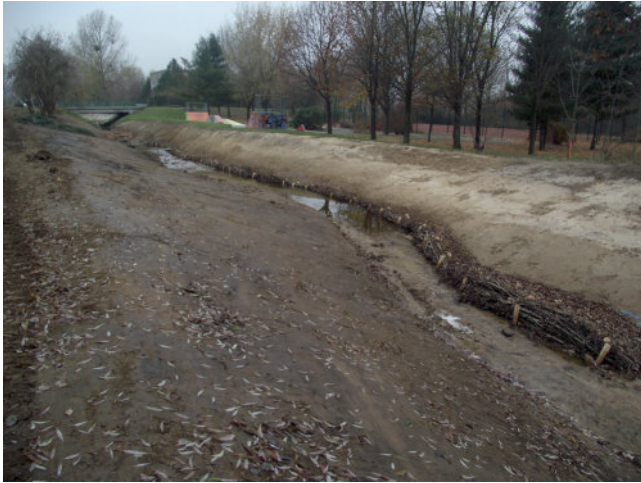
Foto 1: Bei strömungsparallelem Einbau von Lebendfaschinen wird der Böschungsfuß vor Erosion geschützt. (Foto: A. Stowasser)
