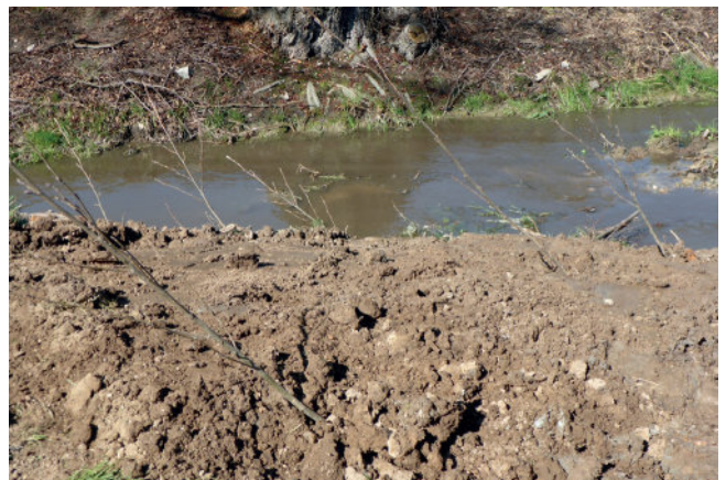
Foto 18: Die Gehölze werden in Reihen angeordnet gepflanzt. Die Neigung der Pflanzen in Fließrichtung verhindert Überflutungsschäden kurz nach der Pflanzung. (Foto: A. Stowasser)
