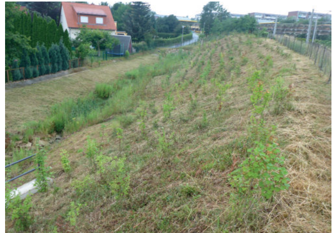
Foto 24: Die Mulchmähd verschafft den Jungpflanzen Wuchsvorteile gegenüber der Konkurrenz der Gräser. (Foto: A. Stowasser)
