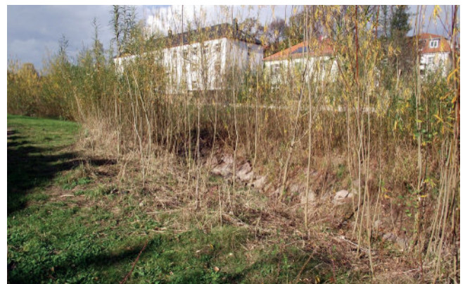
Foto 28: Zustand nach dem Rückschnitt der Lebendbauweise in der Entwicklungspflege. (Foto: A. Stowasser)
