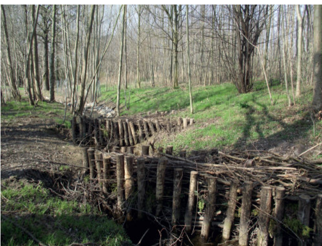
Foto 101: Soll Totholz vor Ort oder an anderer Stelle fixiert werden, sind Totholzbuhen eine Möglichkeit der Fixierung des Materials. (Foto: A. Stowasser)
