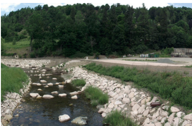
Foto 59: Ufersicherung mit ingenieurbiologischen Bauweisen in einem Gewässerabschnitt, dessen Abflussleistung trotz der Begrünung gewährleistet bleiben muss. Austrieb der Weiden in der ersten Vegetationsperiode; Zielvegetation Strauchbestand. (Foto: A. Stowasser)
