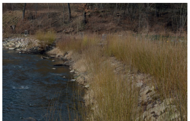
Foto 60: Der aus den ingenieurbiologischen Bauweisen entwickelte Ufergehölzbestand ist aufgrund des regelmäßigen Auf-den-Stock-setzens auch sieben Jahre nach Bau fertigstellung weiterhin strauchförmig und niedrig. (Foto: A. Stowasser)
