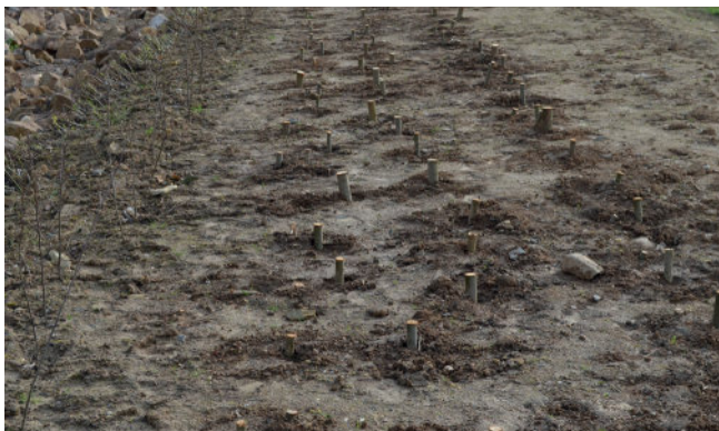
Foto 7: Steckhölzer max. 5 cm über der Böschungsoberfläche glatt absägen. (Foto: A. Stowasser)
