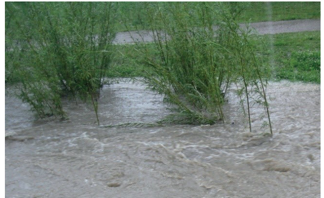
Foto 26: Der noch junge Austrieb der Faschinen nimmt auch bei Überflutung oder Überstauung keinen Schaden. (Foto: A. Stowasser)
