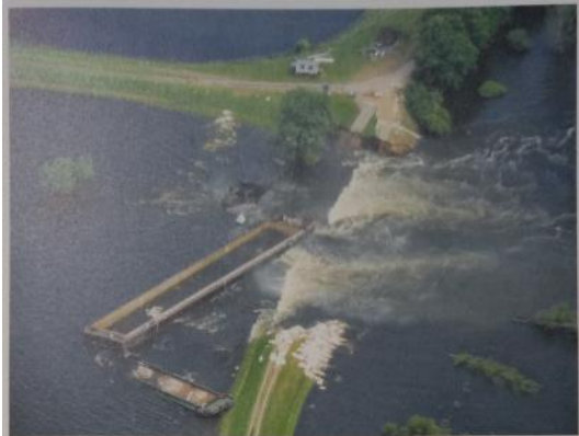
Bild 3: Schließung des Deichbruches Fischbeck durch Versenkung von Schiffen und anschließenden Bau eines Notdeiches (Aufnahme am 16.06.2013, 10:57 Uhr) (Quelle: Jüpner)
