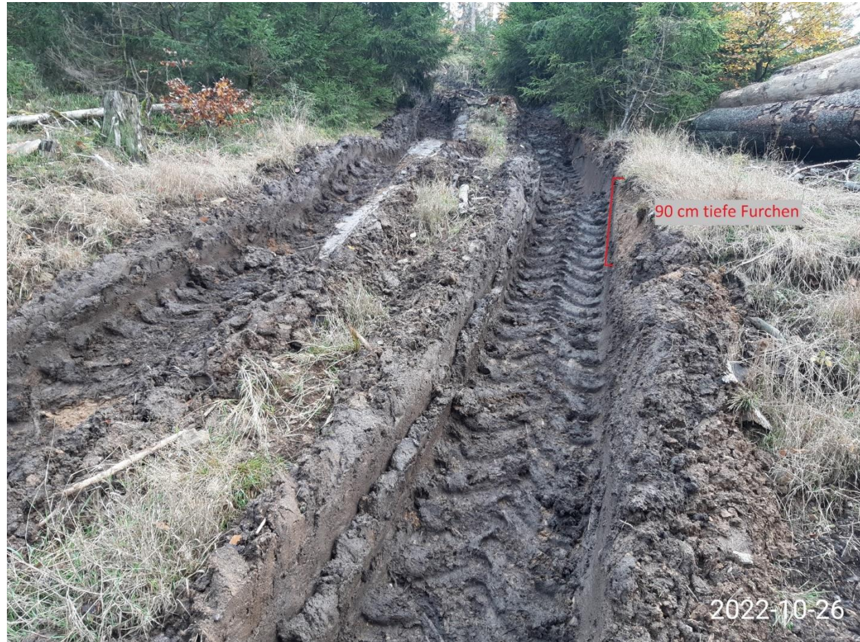
Begehung des Einzugsgebiets der Talsperre Schönbrunn am 26. Oktober 2022
