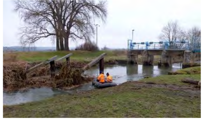
Abbildung 37: Beseitigung des Abflusshindernisses (Quelle: Eichholz, Norbert)
