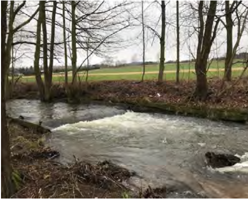
Abbildung 8: Sohlschwelle (Quelle: TLUBN)
