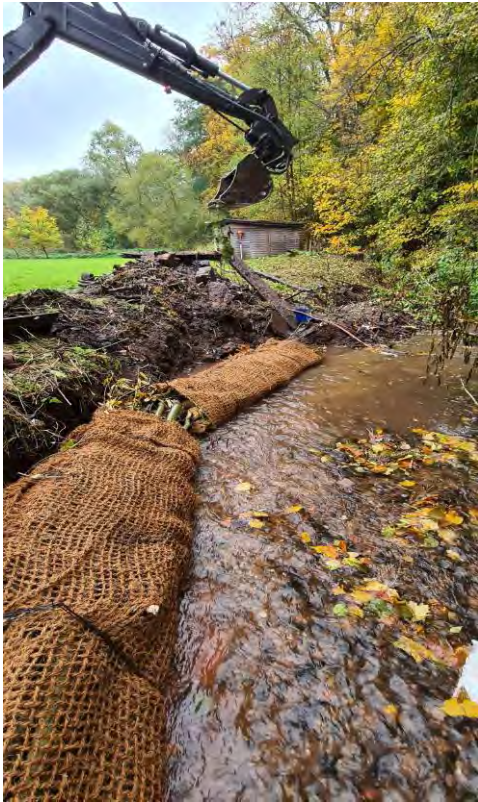
Abbildung 38: Ufersicherung durch Kokoskwalzen am Stübnitzbach in Bad Köstritz OT Hartmannsdorf (Quelle: GUV Weiße Elster/Saarbach)
