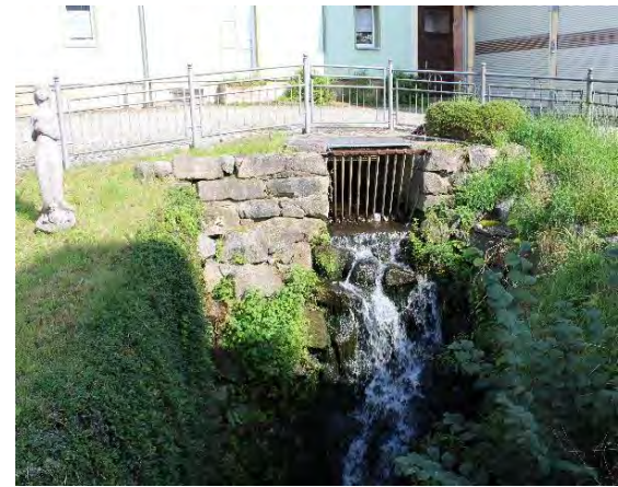
Abbildung 79: Absturz Wassergraben in die Verrohrung in Schleusingen (Quelle: TMUEN)
