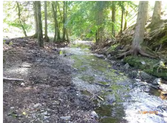
Abbildung 35: Abflussprofil nach der Beräumung (Quelle: GUV Steinach/Itz)
