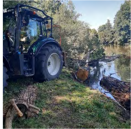
Abbildung 59: Arbeiten an der Saale bei Ammerbach (Jena) (Quelle: GUV Untere Saale/Roda)
