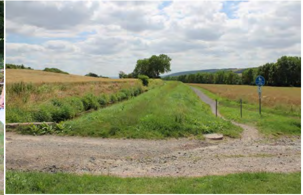
Abbildung 75: Kanaldammstrecke Kleine Wipper (Quelle: TMUEN)
