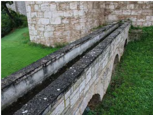
Abbildung 76: Breitsülze, Aquädukt Stadtgraben (Quelle: TMUEN)
