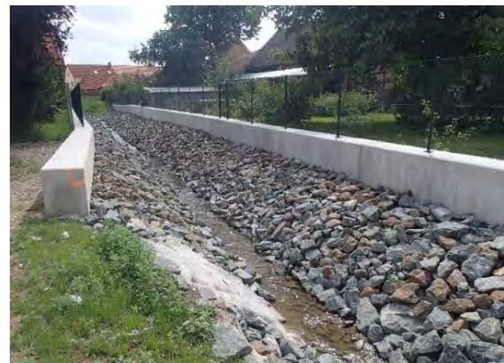
Abbildung 15: Hochwasserschutzwand am Wiesenbach in (Quelle: ThLG)
