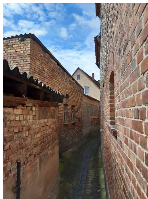
Abbildung 72: Bach aus Jenalöbnitz (Quelle: GUV Untere Saale/Roda)
