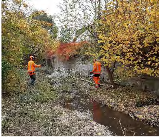
Abbildung 36: Gehölzpflege im Mühlgraben in Laasdorf bei Jena (Quelle: GUV Untere Saale/Roda)
