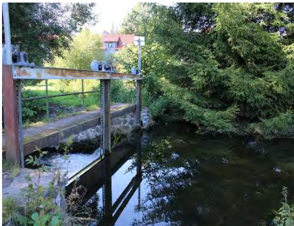
Abbildung 78: Nahwehr - Einlaufbauwerk Wassergraben (Quelle: TMUEN)
