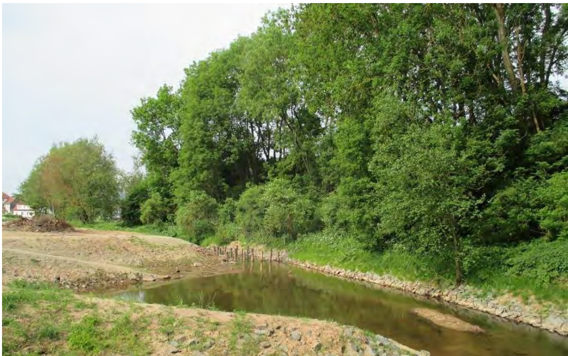
Abbildung 10: Absetzbecken zur Aufnahme von Schlamm- Schluff- oder Lehmlagerungen (Quelle: TLUBN)
