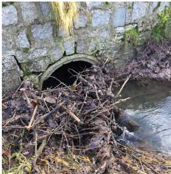
Abbildung 19: verklauster Durchlass (Quelle: TAB)
