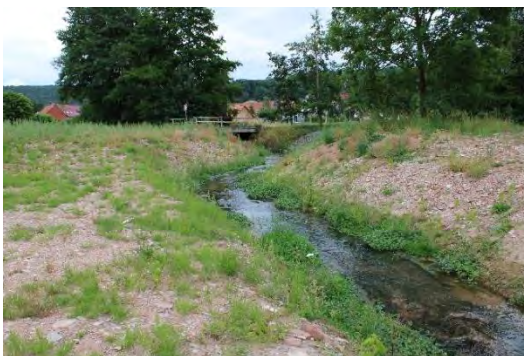
Abbildung 41: Walsemündung kurz nach Beendigung der Bauprojektes (Quelle: TMUEN)
