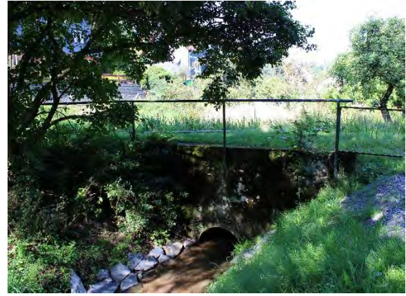
Abbildung 81: Aquädukt Wassergaben/ Silbach (Quelle: TMUEN)
