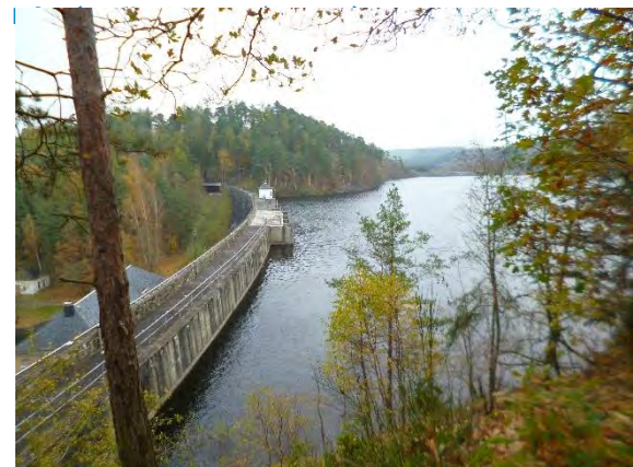
Abbildung 17: Talsperre (Quelle: TLUBN)
