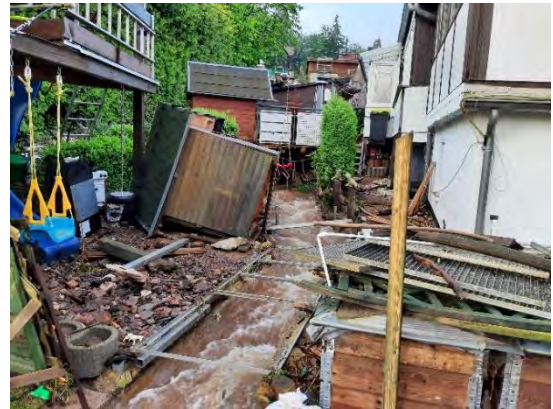
Abbildung 98: Starkregenereignis Mosbach, Hochwasserschäden (Quelle GUV Hörsel/Nesse)
