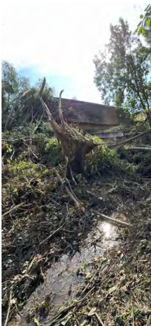
Abbildung 93: Schäden am Huldenbach in Gebstedt Sturmschäden (Quelle: GUV Untere Ilm; Gläßer, L.)
