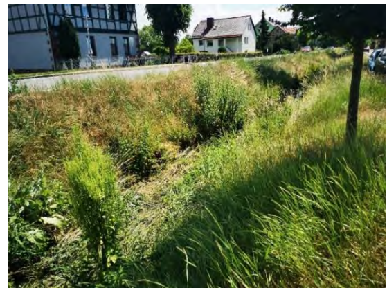
Abbildung 5: Bewuchs im Abflussquerschnitt (Quelle: GUV Helme/Ohne/Wipper)
