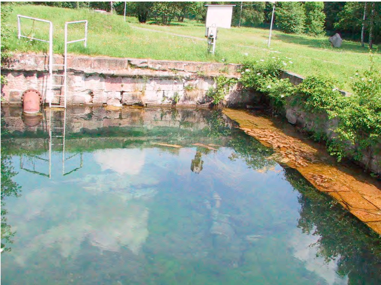
Abbildung 41: Gespringquelle, Schmalkalden (Quelle: TLUBN)
