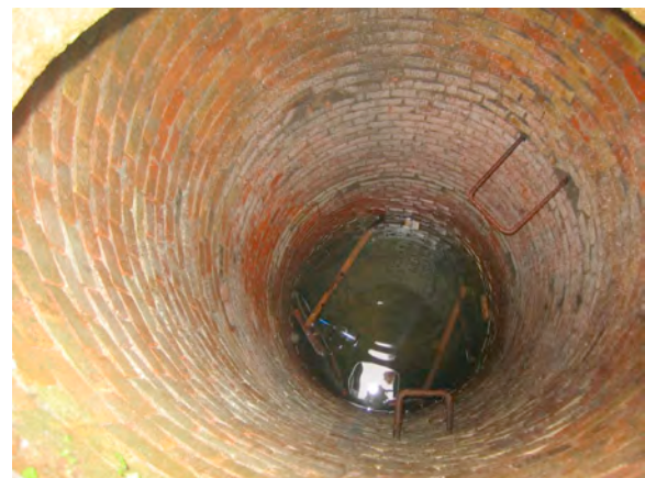
Abbildung 50: Blick in einen Wasserbrunnen (Quelle: ThLG)
