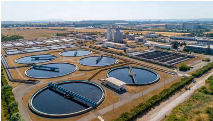
Abbildung 11: Luftbild der Kläranlage Kühnhausen (Quelle: Erfurter Entwässerungsbetrieb)
