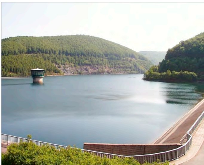
Abbildung 58: Trinkwassertalsperre Schönbrunn in Südthüringen (Quelle: TFW)
