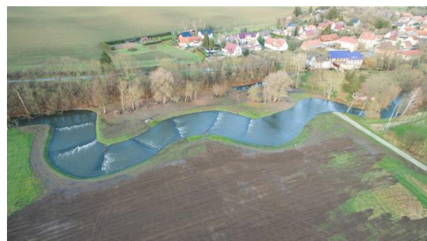
Bild 2: Wehr an der Obermühle in Zottelstedt – vollständige Verlegung der Ilm in das rechte Vorland (Foto: TLUG)
