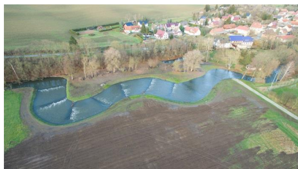
Bild 2: Wehr an der Obermühle in Zottelstedt – vollständige Verlegung der Ilm in das rechte Vorland (Foto: TLUG)
