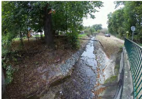
Abbildung 44: Vorhandene Sohlstufe und Sohlschwelle (links);
